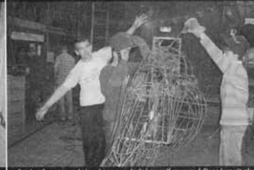
Om het frame van de kop heen wordt de kop zelf gevormd. Deze kop zit al v goede vorm. Mike staat op het punt om weer te gaan lassen, terwijl Laurens aanpassing maakt met zijn bulgijzer. Lars geeft (denken wij) op de achtergrond hoe groot de kop wordt.
