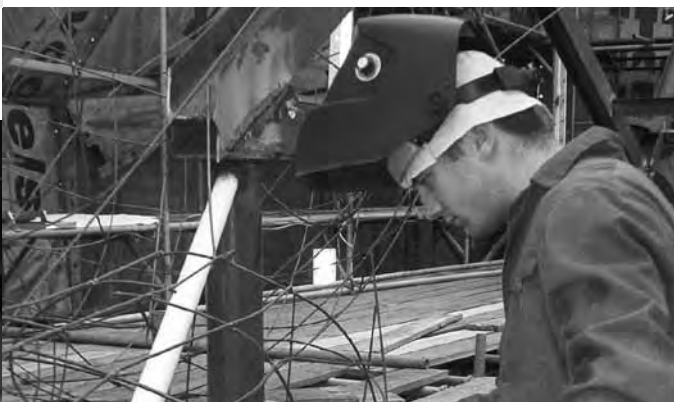
Het begon nog zo gemakkelijk, het lassen. Op werkhoogte en zonder obstakels kan Carlo hier de linkervoet van de vrouw vastzetten. Later zou het een stuk lastiger worden...
