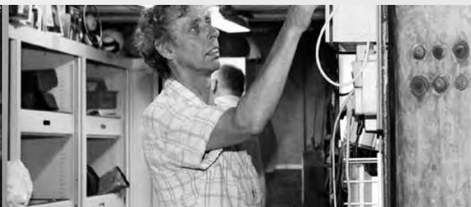
Jan Haazen had het druk aan het begin van het jaar. Tegen de tien lasapparaten moeten kunnen draaien op onze stroomvoorziening, terwijl ook verlichting hierbij wel makkelijk is.
